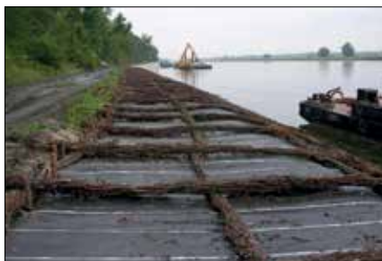
Fot. 4–7. Kolejne etapy zabudowy brzożów rzeki z filtrem geosyntetycznym, rusztem faszynowym i narzutem kamiennym
