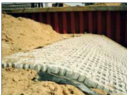
Fot. 8–11. Zabudowa ochronna wlotu i wylotu pomp elastycznymi materacami z bloczków betonowych układanych bezpośrednio na geotkaninie
