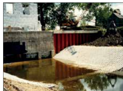
Fot. 8–11. Zabudowa ochronna wlotu i wylotu pomp elastycznymi materacami z bloczków betonowych układanych bezpośrednio na geotkaninie
