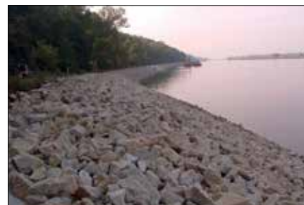
Fot. 4–7. Kolejne etapy zabudowy brzożów rzeki z filtrem geosyntetycznym, rusztem faszynowym i narzutem kamiennym
